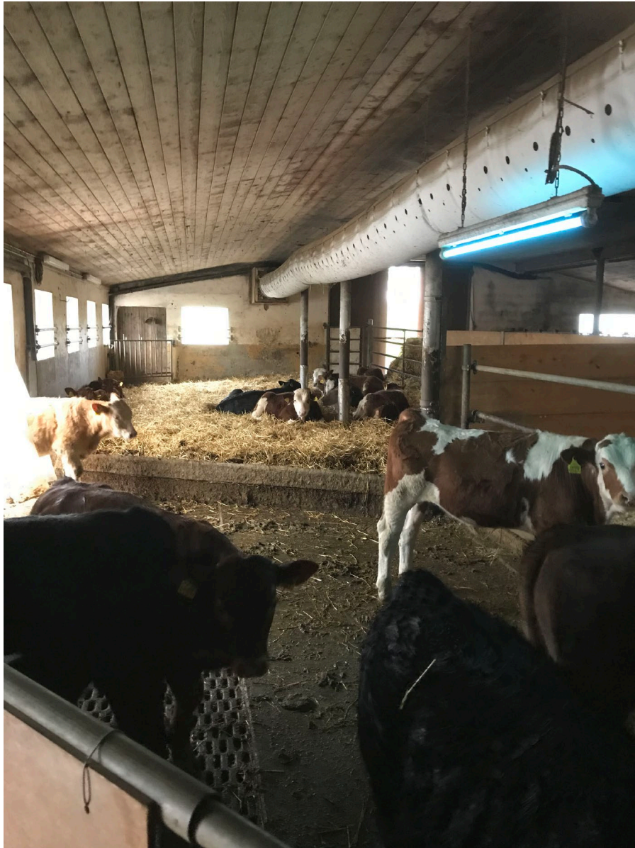
Abb. 2: Schlauchlüftungen ermöglichen in Kälberställen die Zufuhr grosser Mengen an Frischluft bei sehr niedriger Luftgeschwindigkeit
